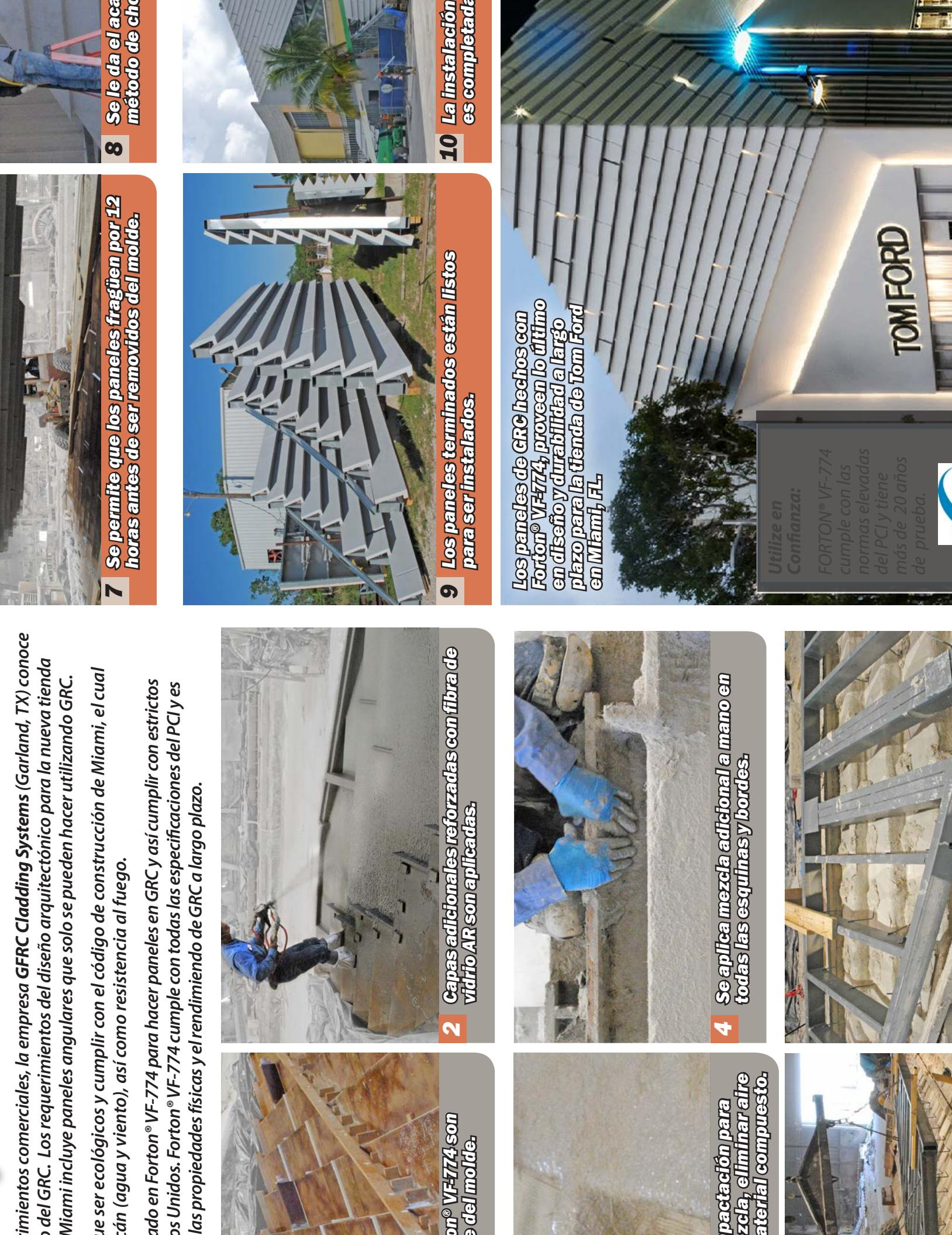
imientos comerciales, la empresa **GFRC Cladding Systems** (Garland, TX) conoce del GRC. Los requerimientos del diseño arquitectónico para la nueva tienda Miami incluye paneles angulares que solo se pueden hacer utilizando GRC. Se permite que los paneles fragüen por 12 horas antes de ser removidos del molde.
