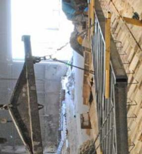
**7** **Se permite que los paneles fragüen por 12 horas antes de ser removidos del molde.**
