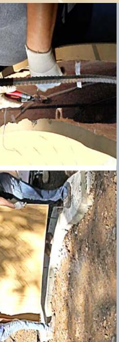
**7** Se posicionan los paneles y se amarran con alambre a las varillas de refuerzo.
